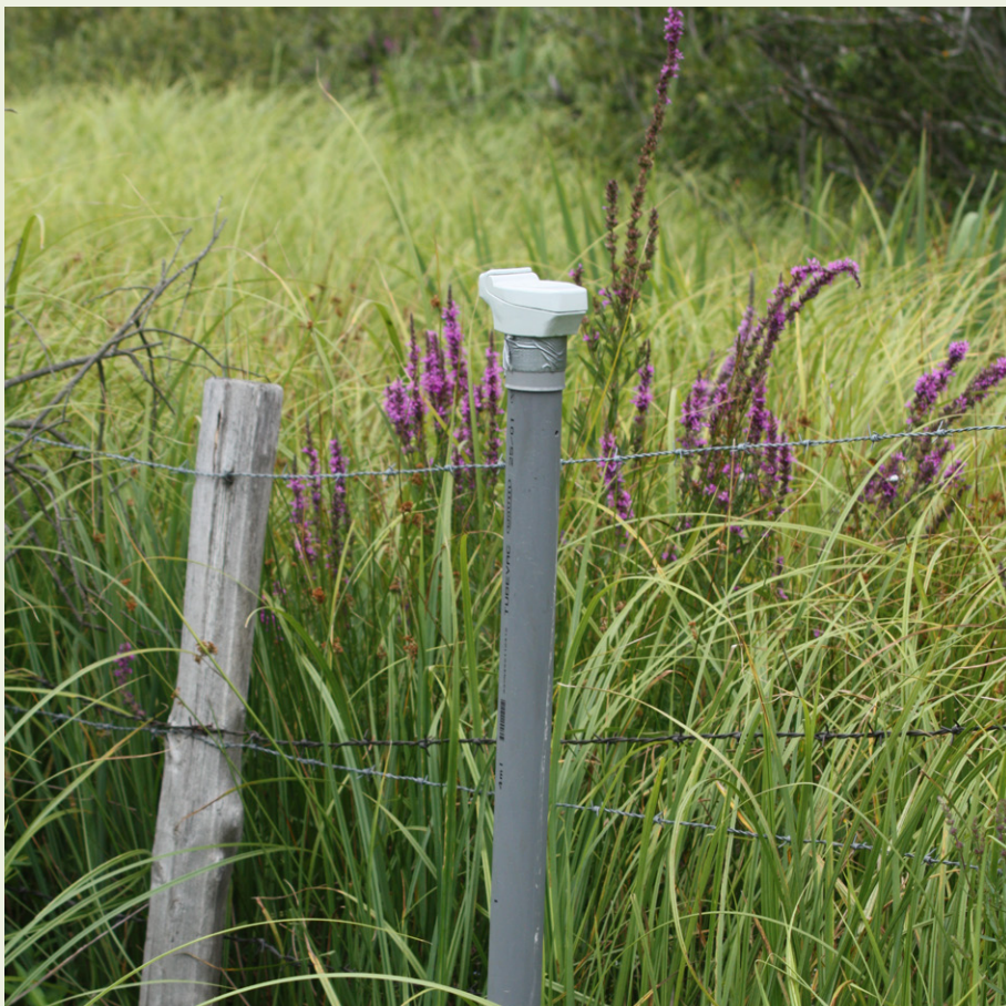
Piezomètre équipé d'une sonde de mesure automatique
